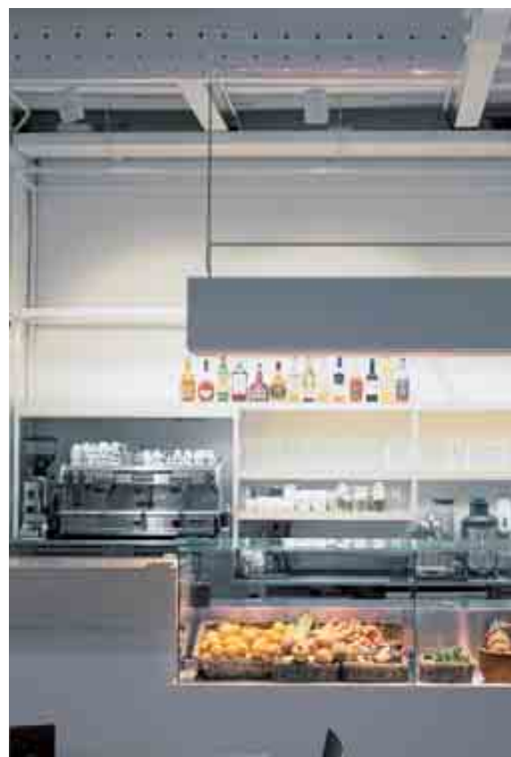
L'impianto di climatizzazione a vista con canali bianchi microforati è la soluzione scelta dal ristorante Good Save the food di Milano,
